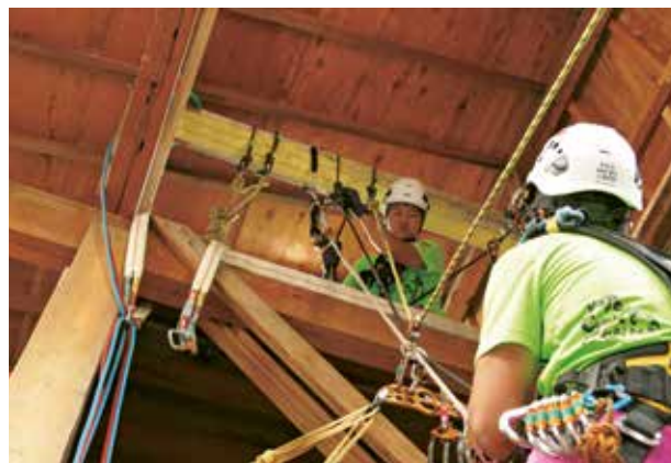
徒手導向繩連接到上方的頂部穩固點。
